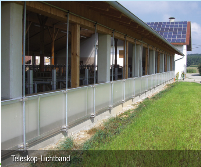
absenkbares Lichtband - elektrisch oder Handbetrieb
